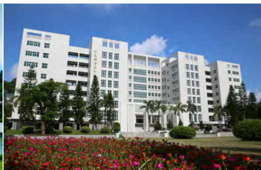
中区信息科技大楼 (22 日下午会场)
